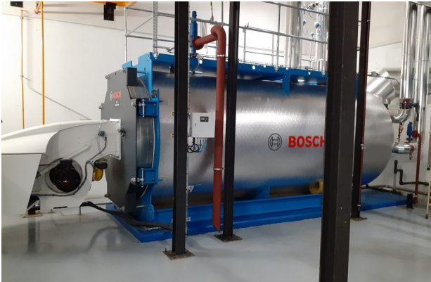
Nouvelle chaudière de 4 MW (G410)
