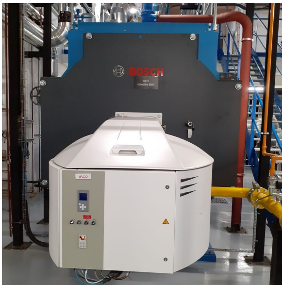
Nouvelle chaudière de 8 MW (G810)
